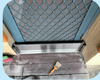
因應急降豪雨一樓教室加裝防水閘門
