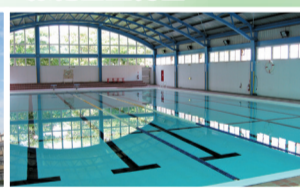
遮陽避雨恆溫室內游泳池
